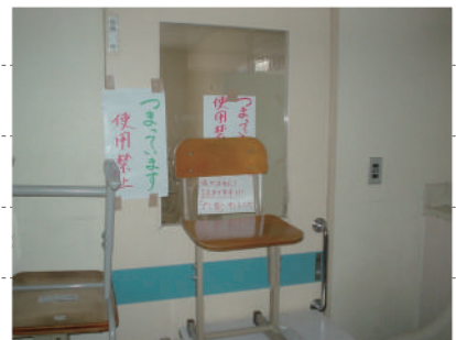
詰まって使用できないトイレ
